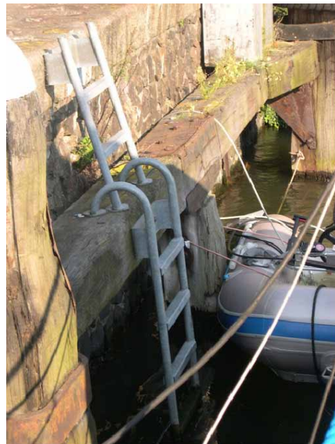
Uitklimvoorziening in de kade
